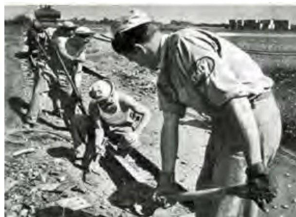
Stati Uniti - Italian Service Units - Lavori stradali
